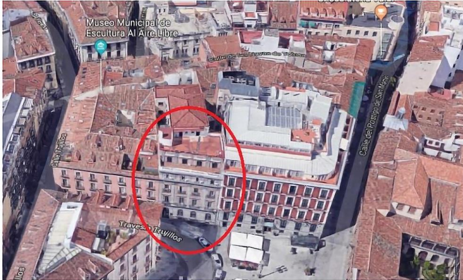
Imagen aérea del Edificio en Plaza de San Martín, nº 4
